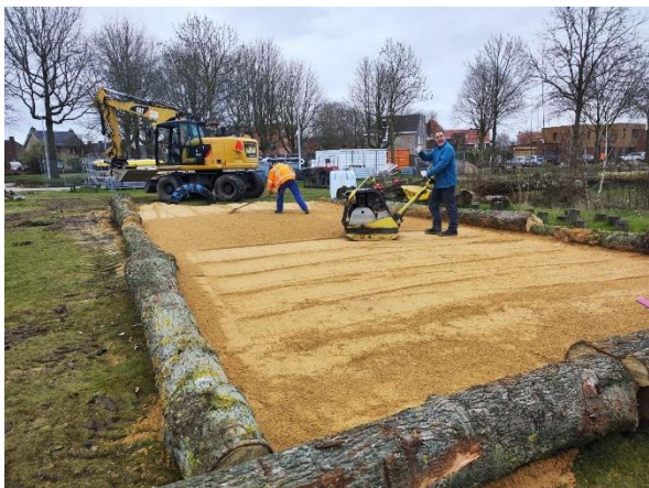
Aanleggen van de jeu de boulesbaan
